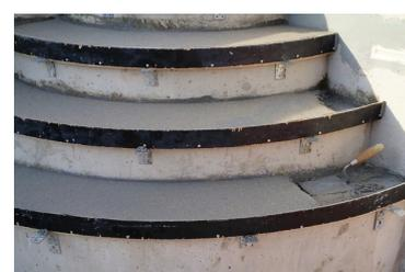
Tragen Sie den Epoxidharzmörtel mit einer Mauerkelle oder Rakel auf den Untergrund auf. Sie können eine maximal 5 cm dicke Schicht pro Arbeits- und Aushärtungsvorgang verarbeiten. Sollten Sie eine höhere Schicht verarbeiten müssen, warten sie bei 20C° 4-12 Stunden. Machen Sie den Finger Test mit einem Handschuh, das Gemisch sollte sich nicht mehr verschieben können. Nach 20 Stunden ist der Epoxidharzmörtel fest und begehbar, nach 7 Tagen Aushärtungszeit komplett belastbar.
