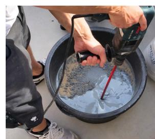
**Verarbeiten** Sie den fertigen Mörtel direkt nach dem Anmischen, beachten Sie das die Reaktion des Gemisches davon abhängig ist in welchem Volumen Behälter es sich befindet. Kunstharz reagiert schneller und wird somit heißer in einem hohen Behälter, wenn man das Harz aber in einem flachen breiten Behälter verwendet dauert die Reaktionszeit länger. Sie haben ungefähr 20 Minuten dafür Zeit, danach wird der Mörtel langsam härter und lässt sich schwerer auftragen.
